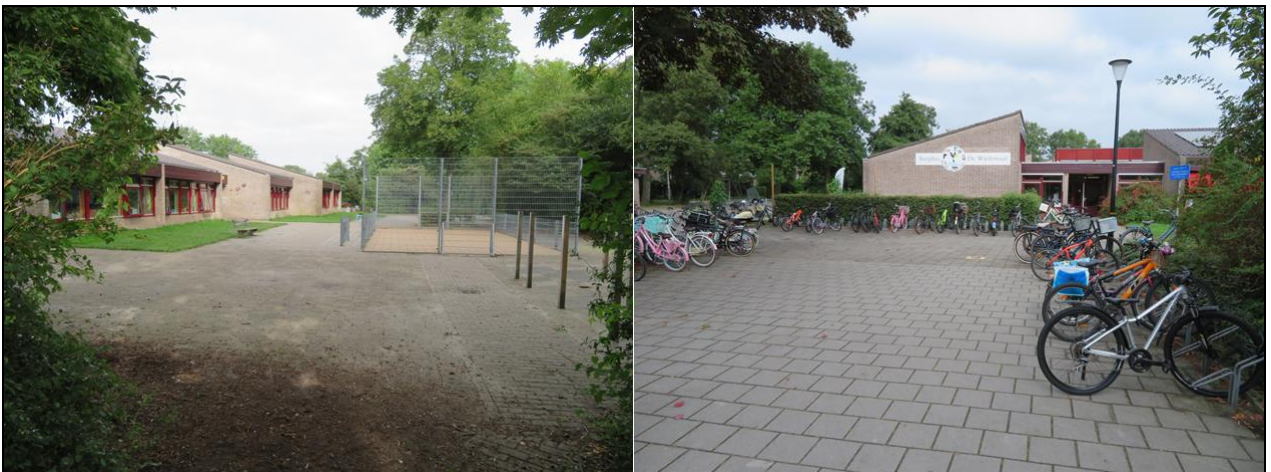
Afbeelding 4: Schoolgebouw 'De Vogelweid'
