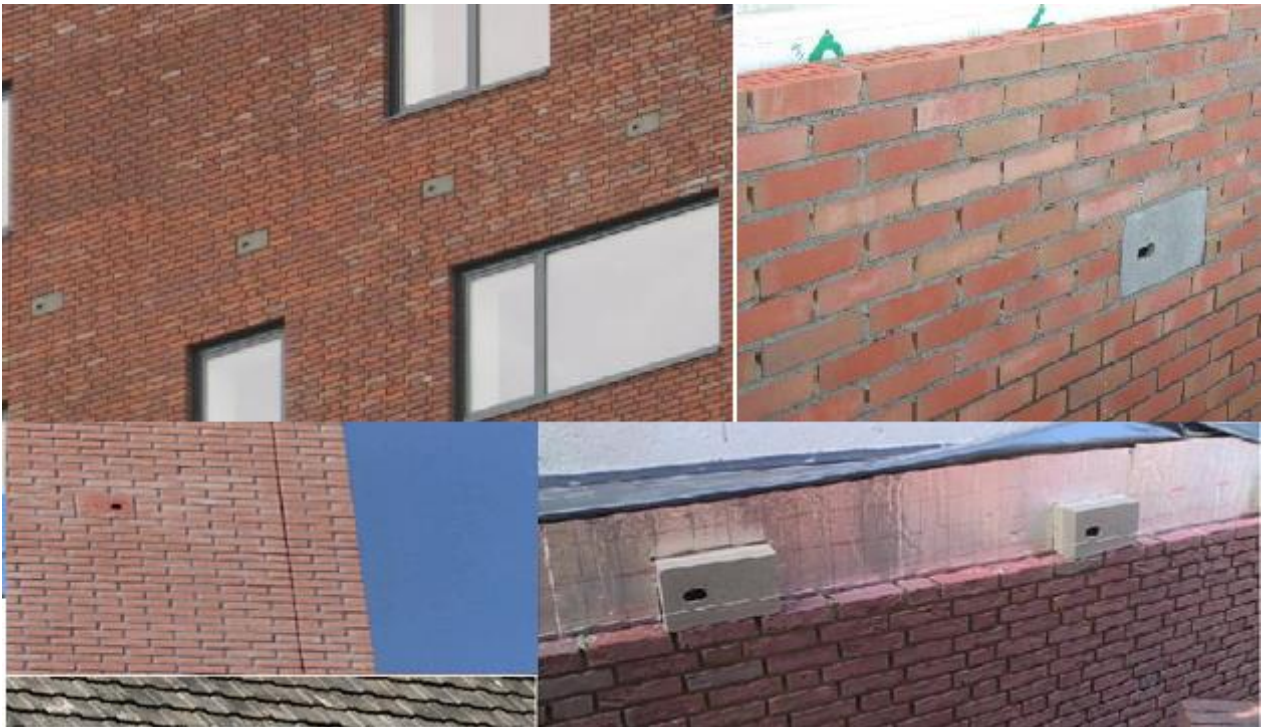
Afbeelding 14b: voorbeelden van vrijwel onzichtbare inbouw van vleermuisstenen en technische informatie over de plaatsing daarvan
