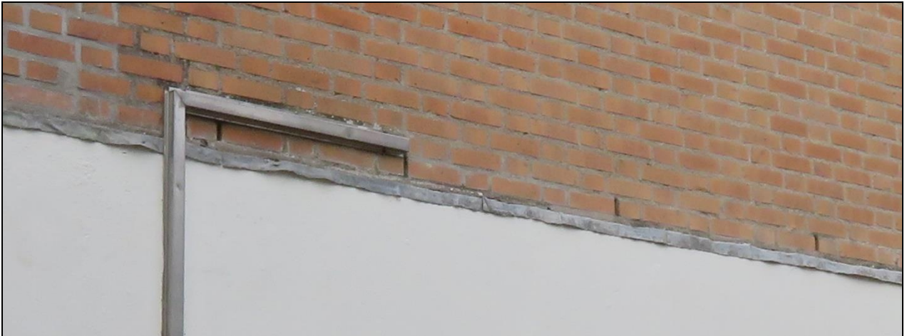
Afbeelding 12: open stootvoegen bij de rode lijnen uit afbeelding 11
