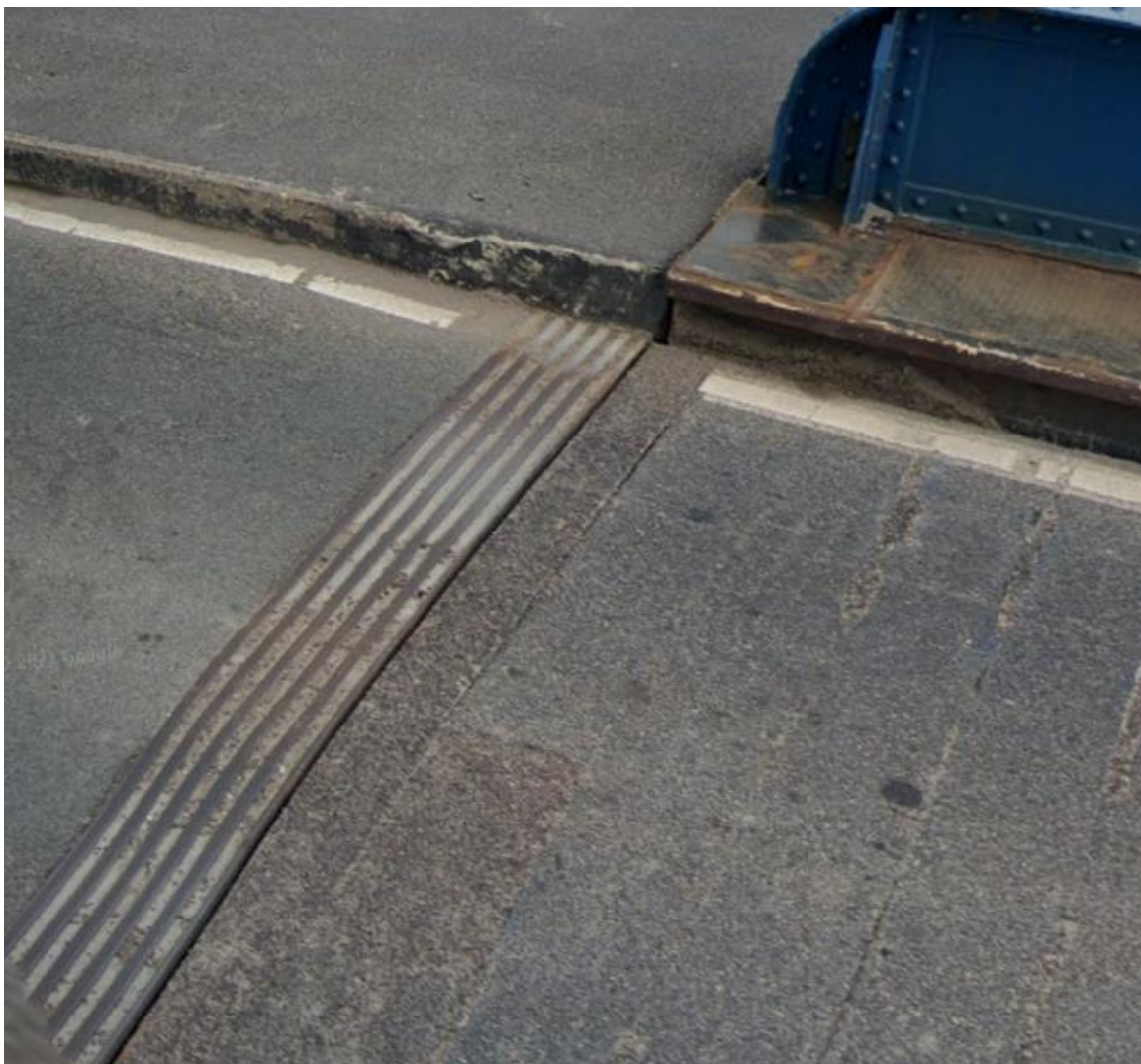
Afbeelding 4.5 Voegspleet bij de overgang tussen het landhoofd en het beweegbaar brugdek in de huidige situatie
