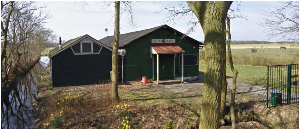
Afbeelding 2: Foto van het inmiddels gesloopte verenigingsgebouw
