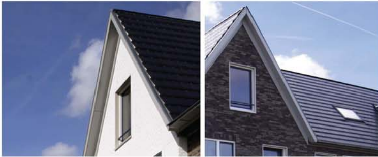
Detailering overstek. Minimaal 30cm (excl. goot).
