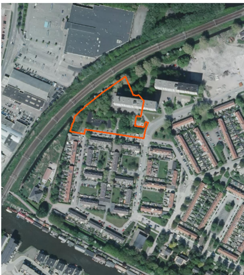
Figuur 1: Luchtfoto van het plangebied in de referentiesituatie. Momenteel ligt het gebied braak.
