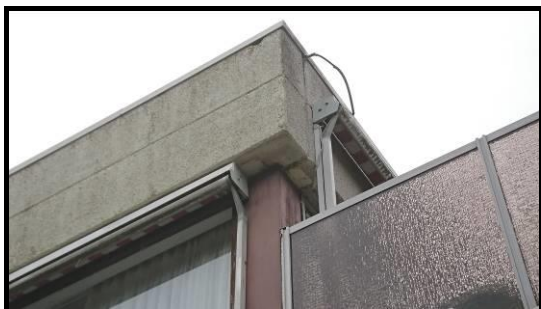
Afbeelding 3: Ruimtes achter zonwering en onder dakrand
