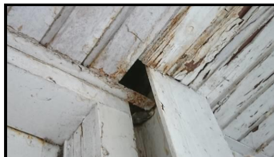
Afbeelding 10: Ruimtes achter houten beplating
