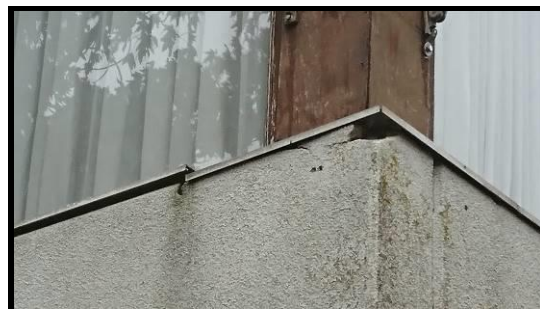
Afbeelding 4: Ruimtes onder aluminium randen
