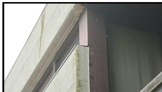
Afbeelding 6: Ruimtes onder aluminium randen
