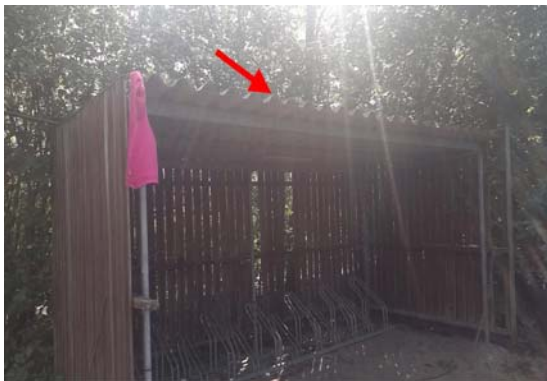
Foto 3 | Foto voor bron golfplaat dak
