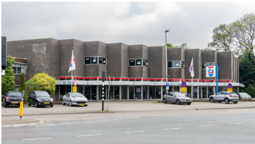
Gevelaanzicht Garage Zijp
