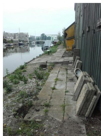
Foto 6, Achterzijde vml Houtloods
