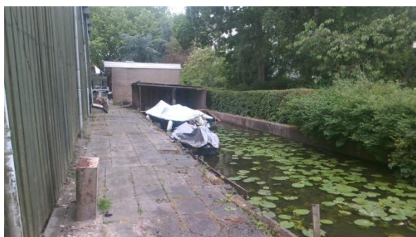
Figuur 9: Insteekhaventje (beton- en houten beschoeiing)
