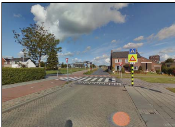
Figuur 3.8: Voorbeeld verkeersveilige fietsoversteek in de voorrang (bron: Cyclomedia)
