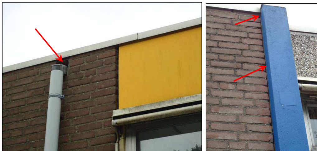
Figuur 4.1. Structuren die mogelijk een verblijfplaats van vleermuizen vormen. Links: gat boven een regenpijp. Rechts: kieren tussen bakstenen en beton.
