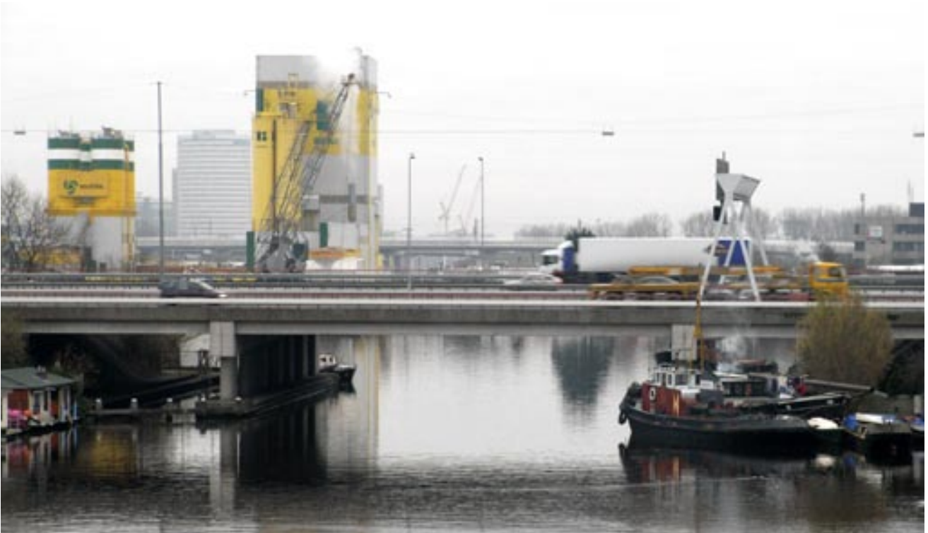
▲ Zicht op de A10 en de betoncentrale
