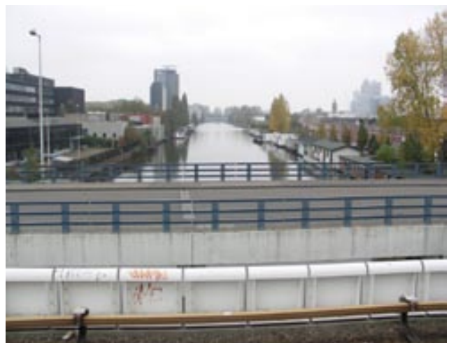
▼ Zicht op de Duivendrechtse Vaart vanaf metrostation Overamstel.
