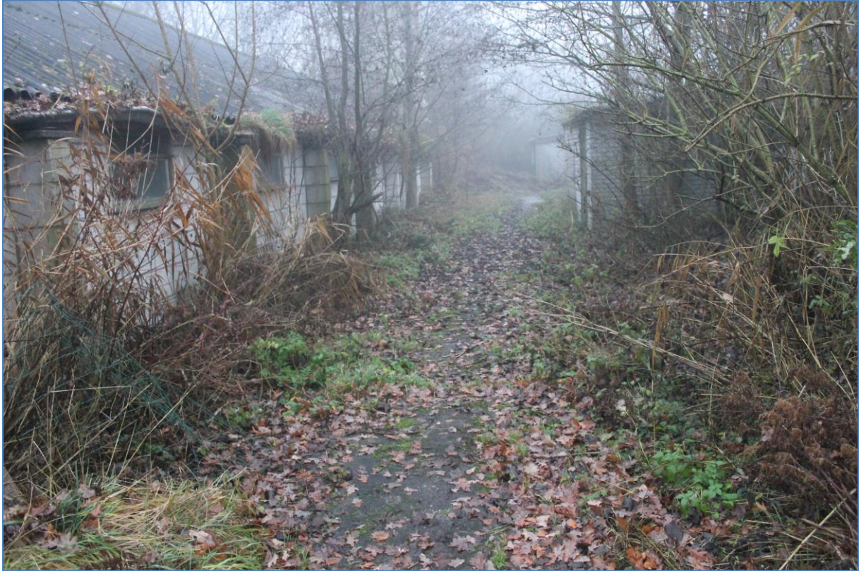
Afbeelding 2. huidige situatie met in verval geraakte opstallen
