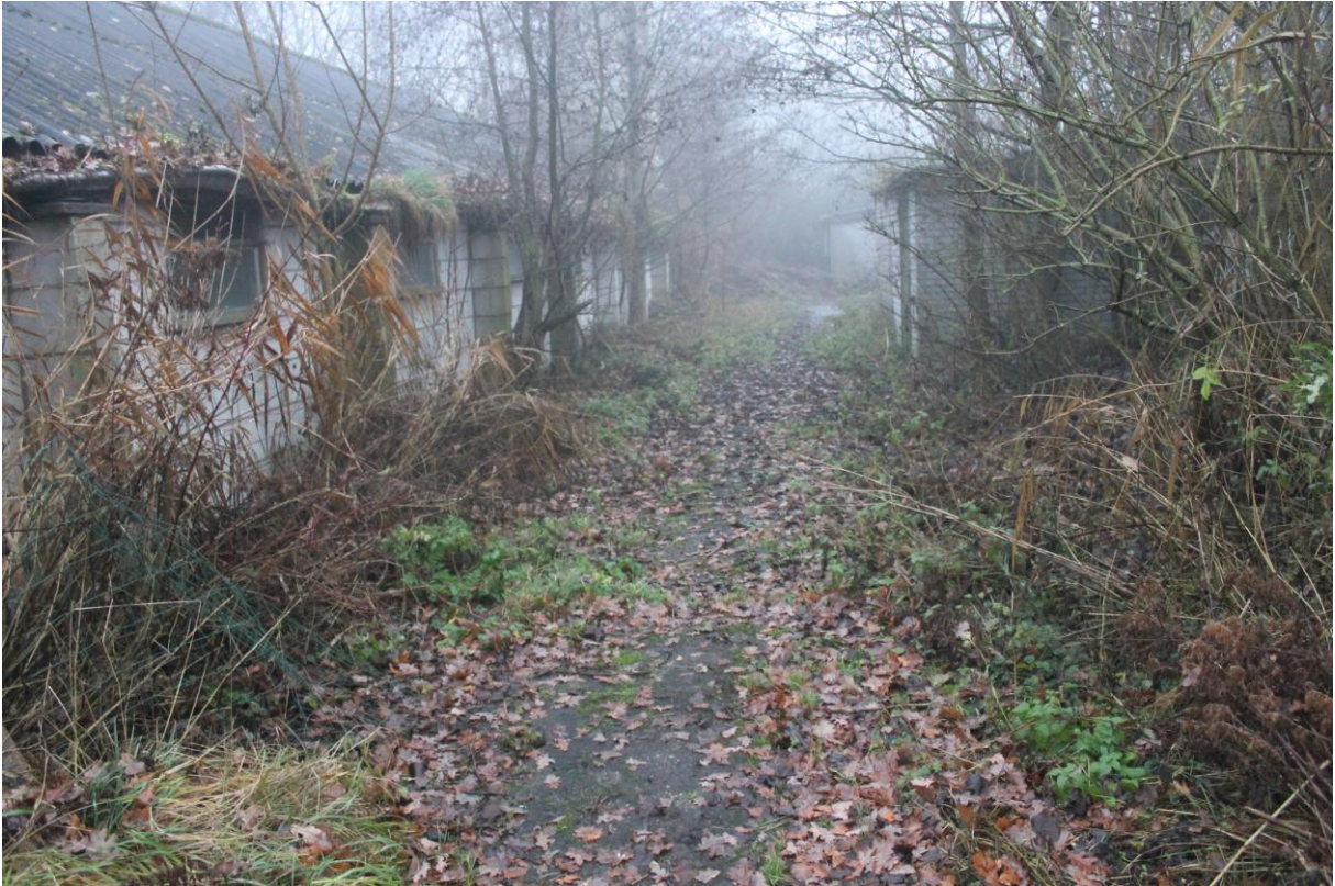
11. Betonnen pad tussen schuur 1 en 2
