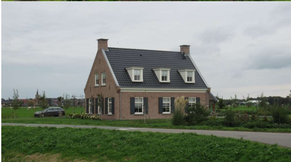
Een voorbeeld van een eenvoudige woning met stevig zadeldak, ondergeschikte haakse aanbouw en karakteristieke details (o.a. gootlijst, schoorstenen, luiken en muurankers). Daarnaast is er een duidelijk onderscheid tussen de grootte van de ramen op de begane grond en de 1 e verdieping. Dakkapellen zijn ondergeschikt vormgegeven.
