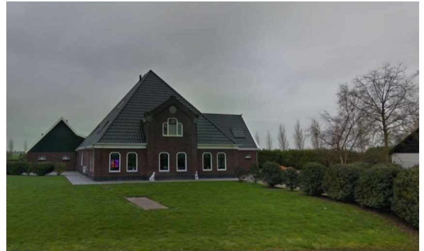
Lage onderbouw incl. stevige kap met topgevel die voorgevel een kwalitatieve uitstraling geeft; ritmiek, stevige goot. Karakteristiek voor het buitengebied is ook het ondergeschikt vormgegeven bijgebouw met een meer sobere architectuur.
