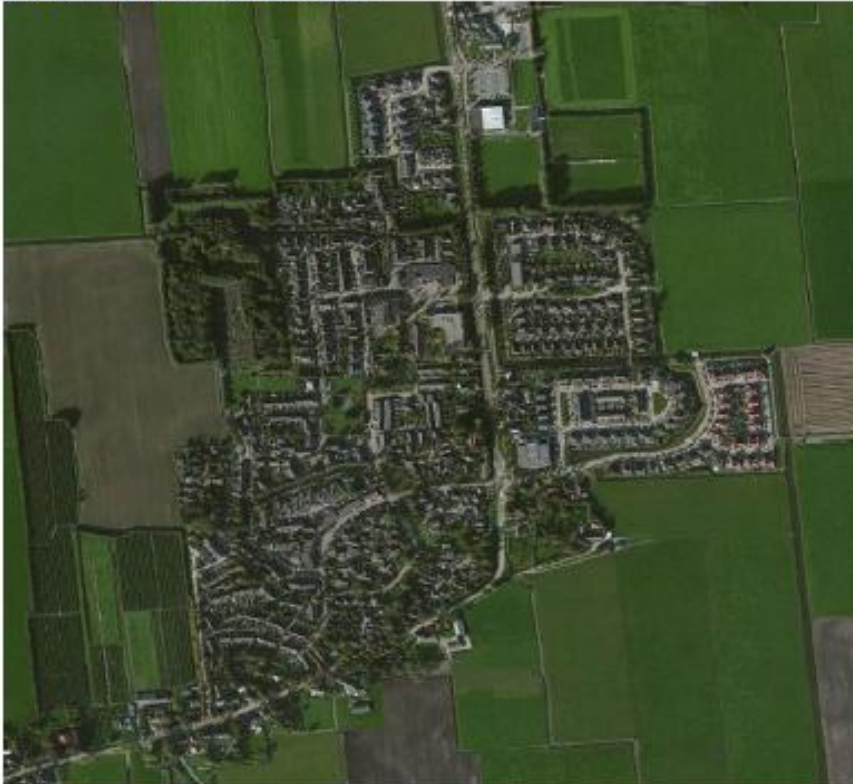
FIGUUR 4 ZICHT IN TRIPKOUW-OOST FASE II
