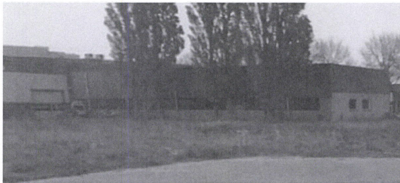
Foto achter- en zijgevel bedrijfshal Randweg 11
