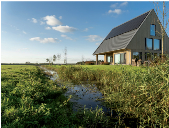
Referentiebeelden architectuur en buitenruimte
