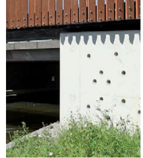
Referentiebeeld zwaluwgaten in brug
