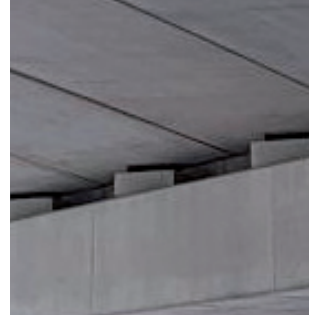
Referentiebeeld vloermuis-verblijfplaats onder brug
