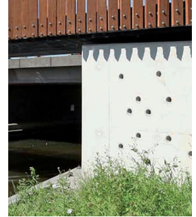
Referentiebeeld zwaluwgaten in brug
