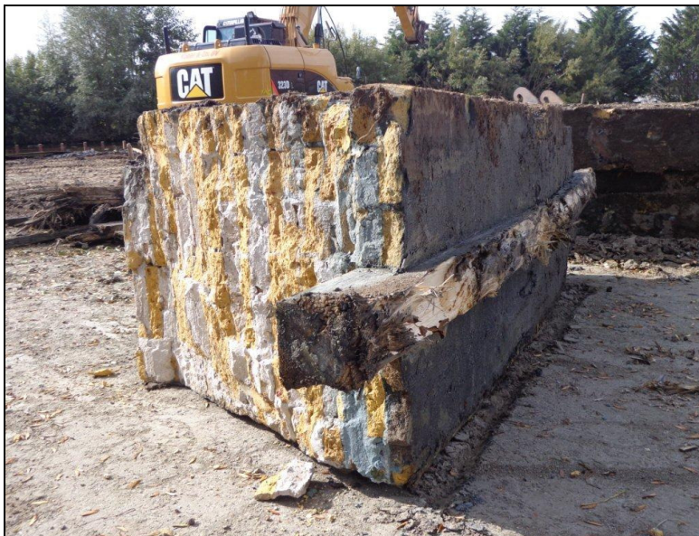
Afb. 4 Een deel van de fundering van één van de molens, die aan de Molenweg hebben gestaan. De molenfundering is uit de grond getrokken tijdens de asbestsanering in 2013 (foto: J. van de Gruiter).
