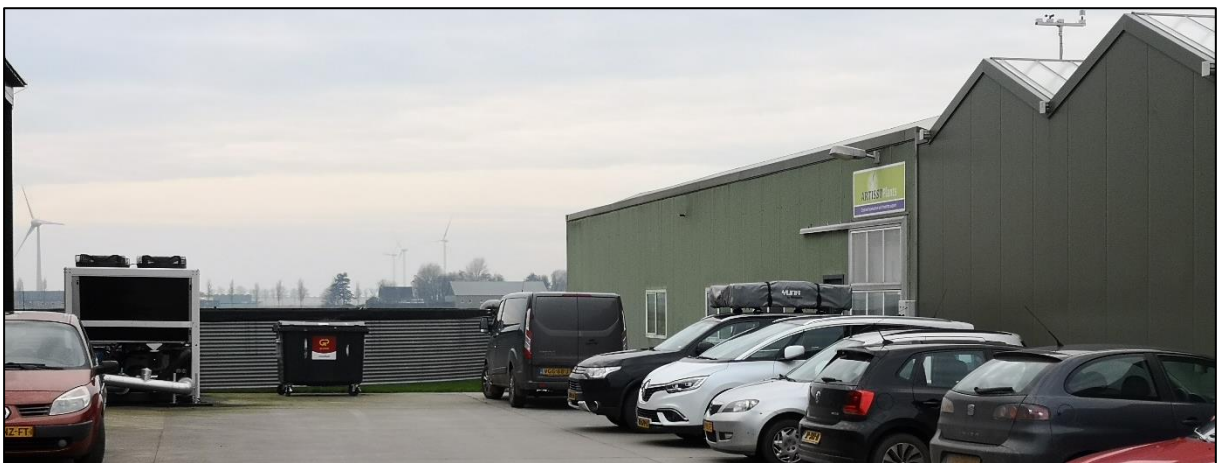
Afb 5: Loods waartegen gebouwd gaat worden
