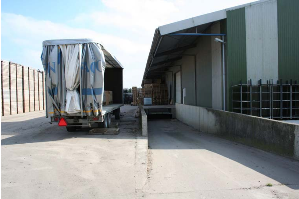
Figuur 11. Bestaande bedrijfsbebouwing naast de bedrijfswoning
