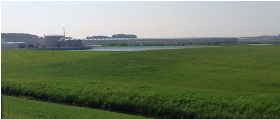
Figuur 18. Voorbeeld van met grondwal ingepast waterbassin
