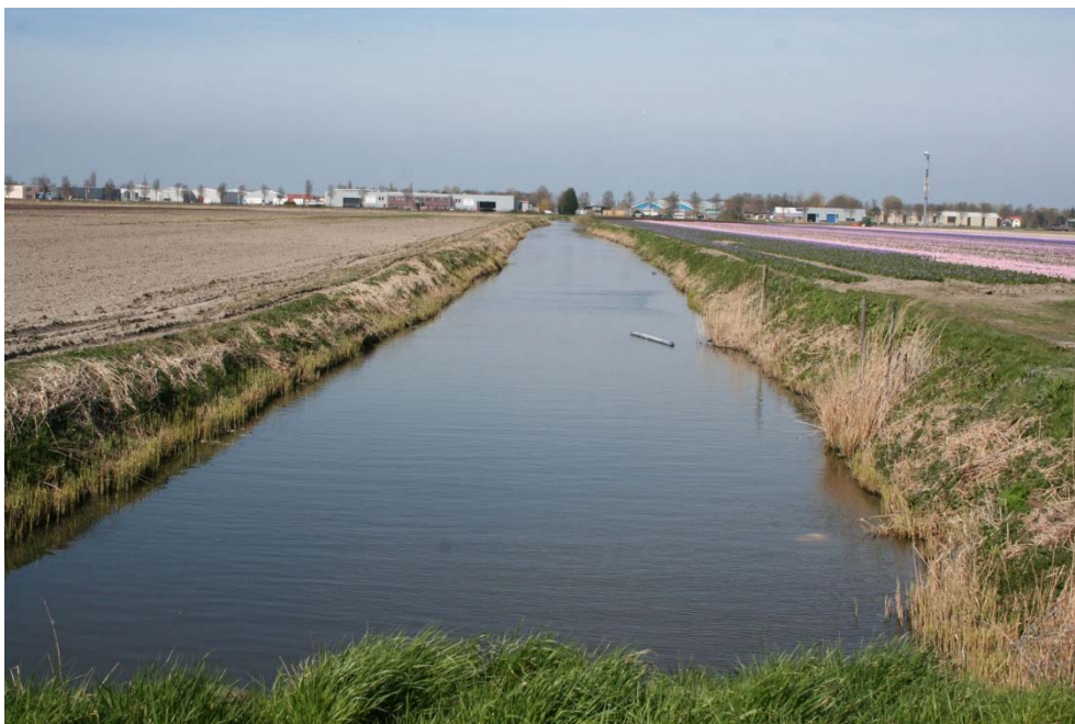
Figuur 6. De bestaande watergangen aan weerszijden van het perceel met op de achtergrond de bedrijfsbebouwing van het bedrijventerrein achter Andijk.
