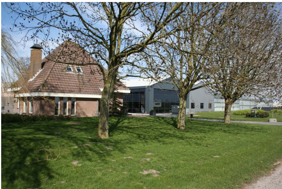
Figuur 9. Bestaande bedrijfsbebouwing naast de bedrijfswoning
