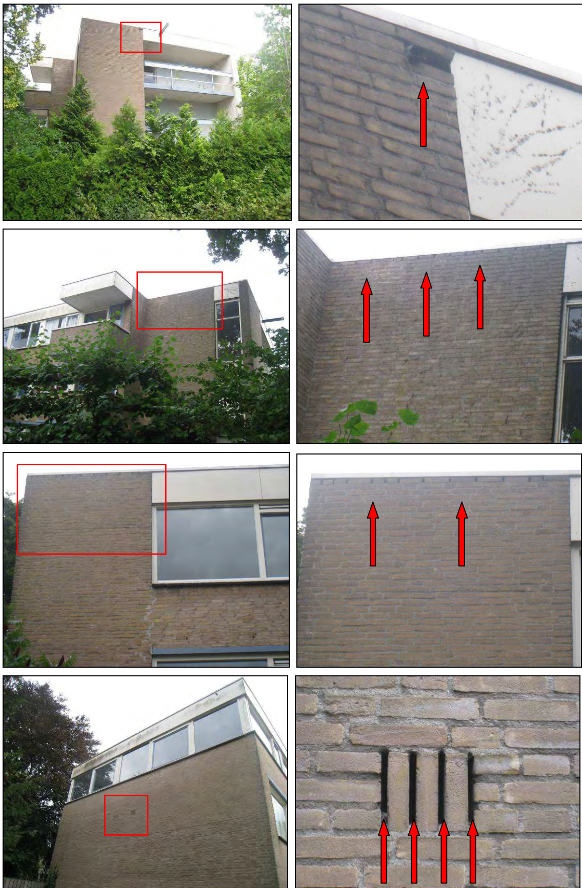
Figuur 3. Potentiele verblijfplaatsen van vlermuizen in de te slopen gebouw Pastoor Hendrikstraat 51 te Laren.
