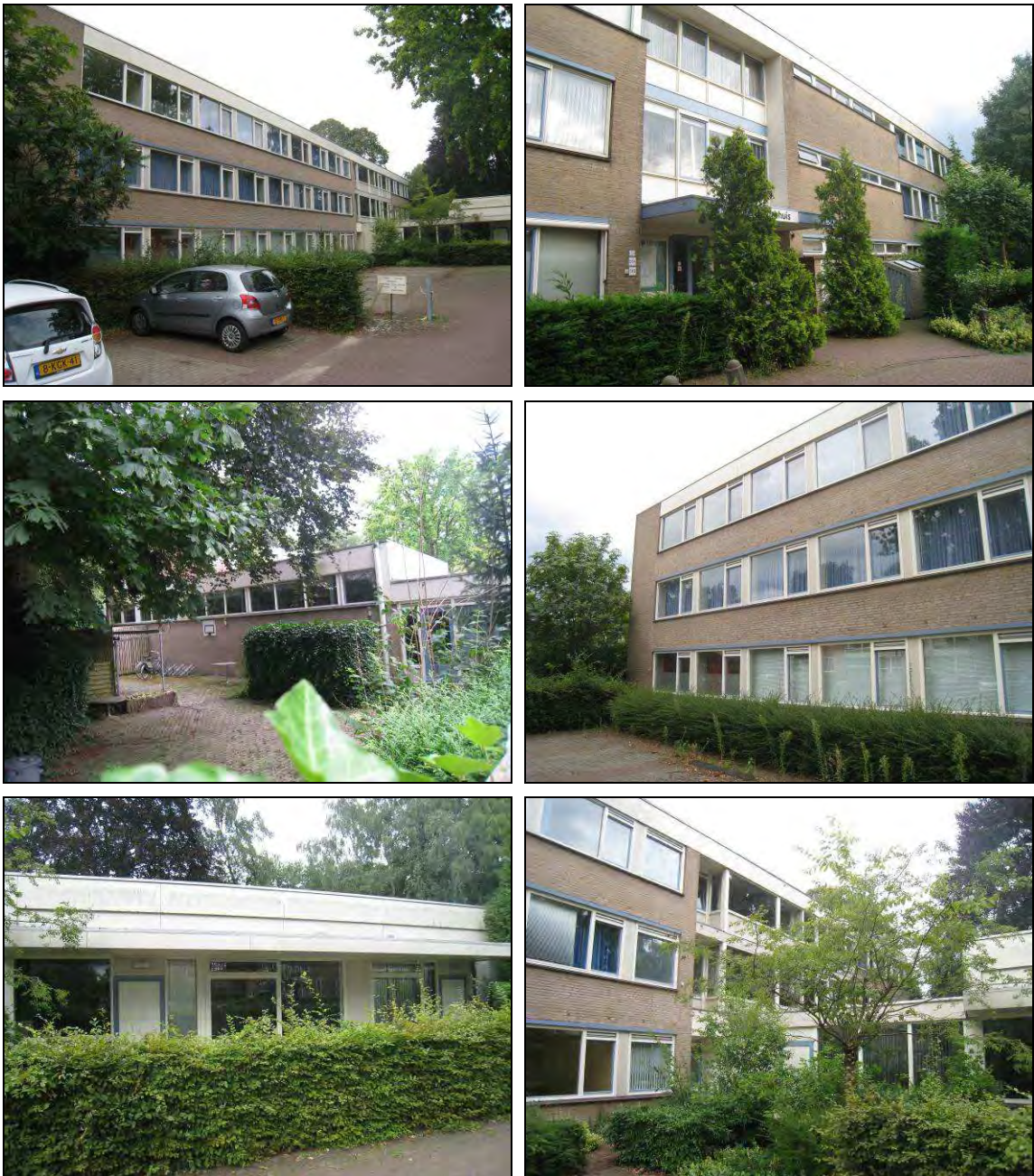
Figuur 2. Aanzicht van de te slopen gebouw Pastoor Hendrikstraat 51 te Laren.
