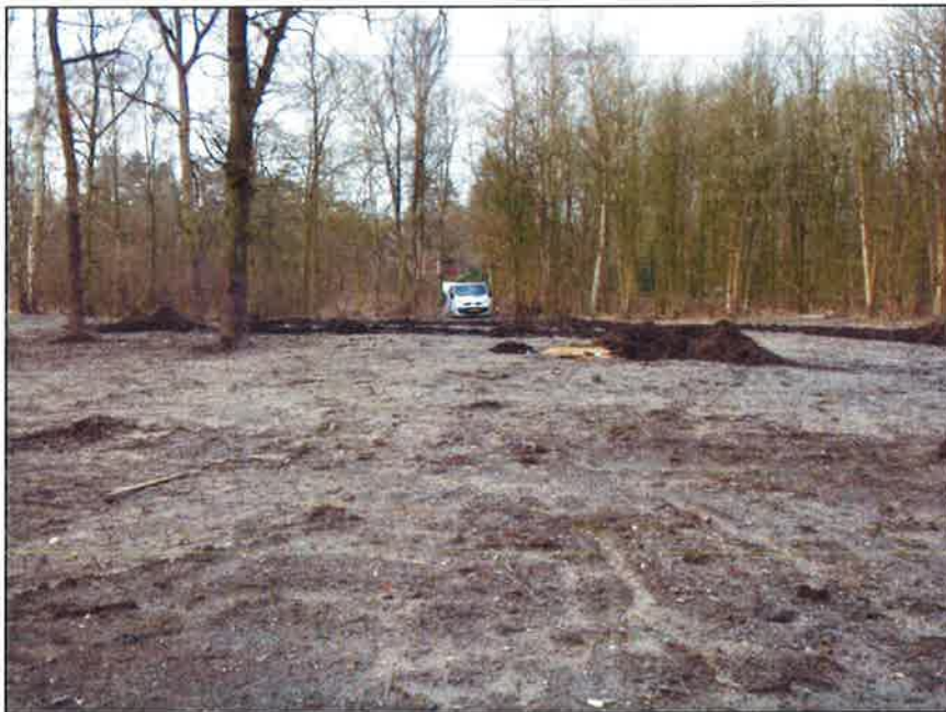
Foto 4 P2012-0378 Bodemonderzoek gronddepot Laren (d.d. 09-03-2012)
