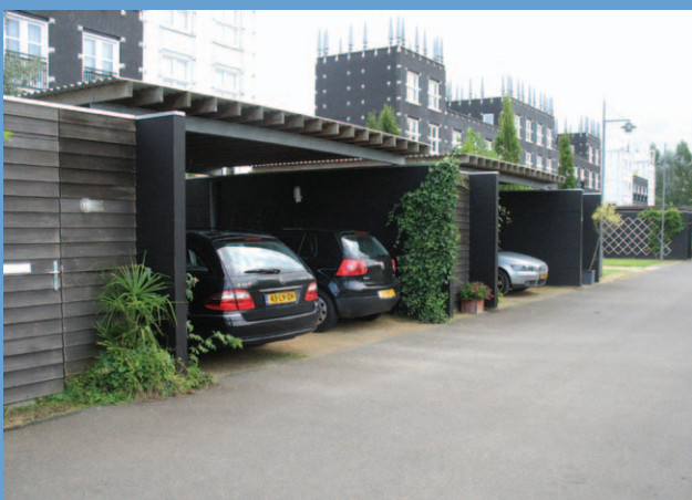
achterzijde aan parkeerkoffer
