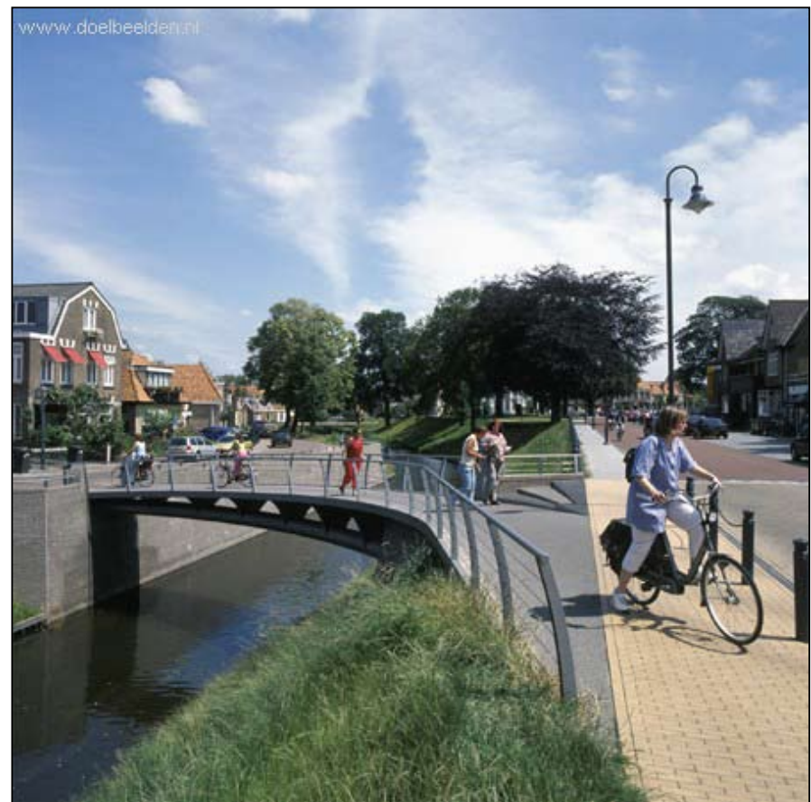
Referentie: ronde brug Steenwijk, toankelijk, helling 1:20
