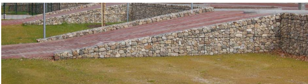
Grondkering met schanskorven
