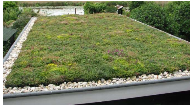
Sedumdak voor carport
