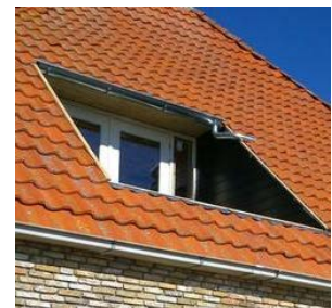
Loggia balkon in dakvlak
