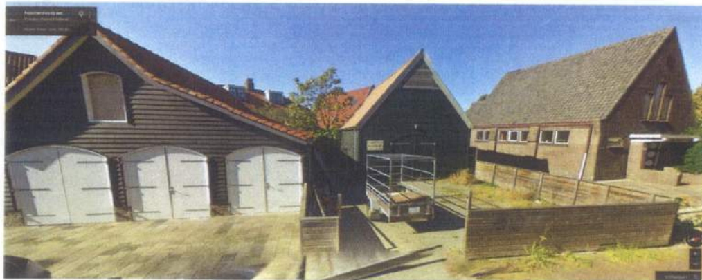
f1.1 Foto huidige situatie (bron: Google Earth)
