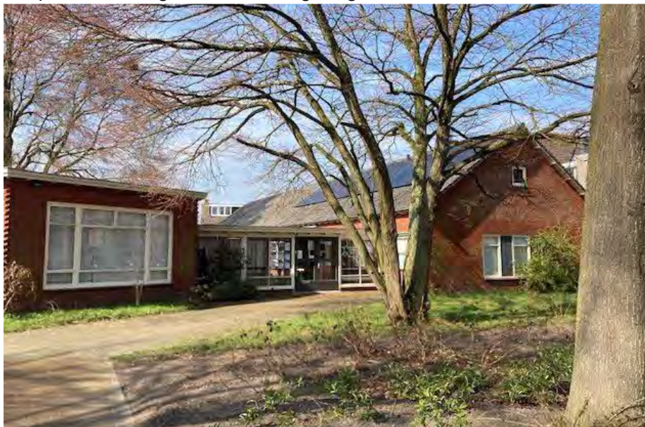
Afbeelding: huidige bebouwing gezien vanaf de Trompstraat
