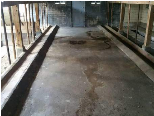
FB08: Gezien het bouwjaar en de gebruikte bouwmaterialen is er geen verwachting van asbestverdachte materialen onder de betonvloer.
