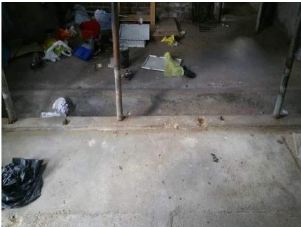
FB10: Gezien het bouwjaar en de toegepaste bouwmaterialen is er geen verwachting van asbestverdachte materialen onder de betonvloer.
