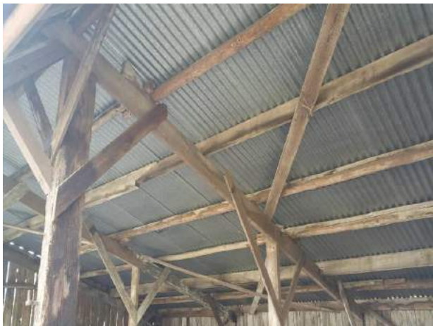
FB02: Het afdak is afgewerkt met metalen golfplaten dakbeplating.
