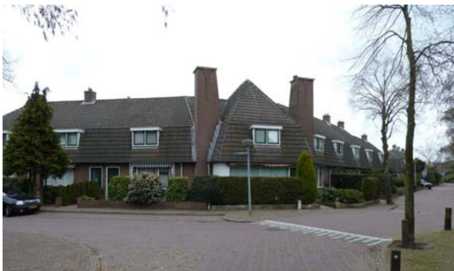
Winkelwoning op de hoek van de Magdalenestraat en Piet Prinsstraat, voorzien van een steekkap en geflankeerd door bakstenen schoorstenen.
