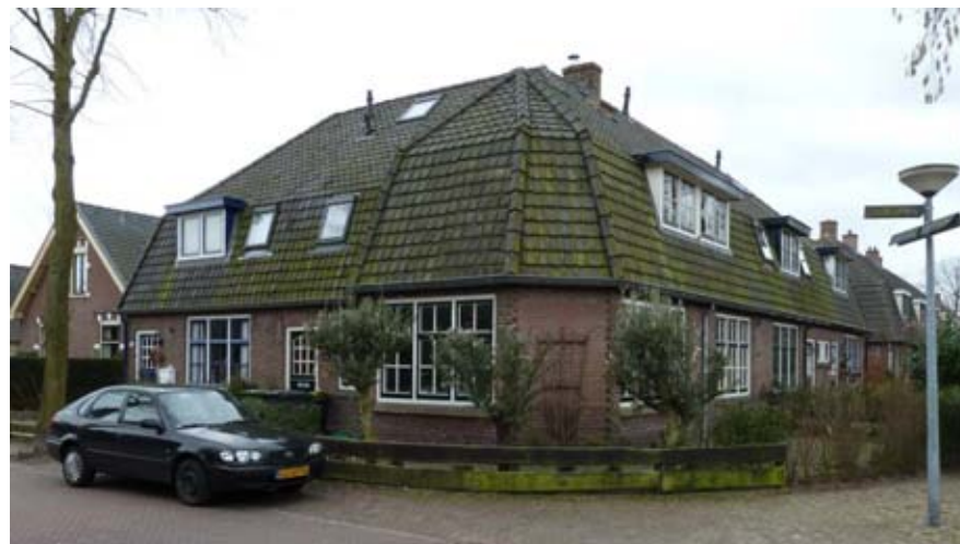
Complex van vier woningen op de hoek van de Piet Prinstraat en Noorderweg. De uitbouw op de hoek bevatte een winkelruimte.
