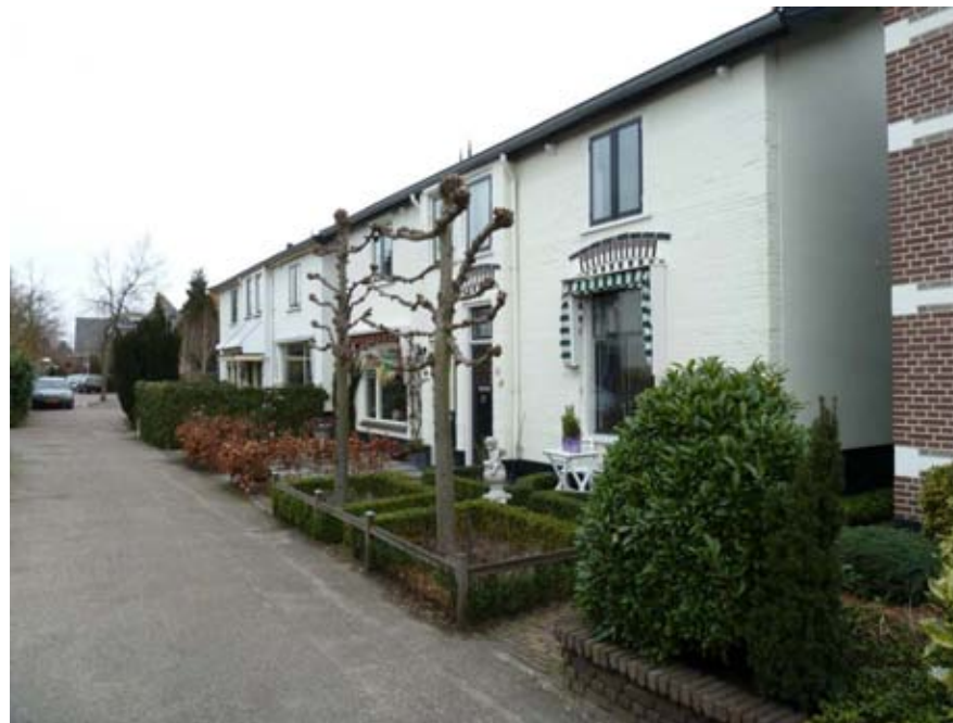
Smallelaan 11-17. Deze dubbelwoningen zijn bij verbouwingen gepleisterd, gewit en voorzien van grote vensters op de begane grond. Verder zijn de geveltoppen verwijderd en aanbouwen aan de achterzijde gerealiseerd.
