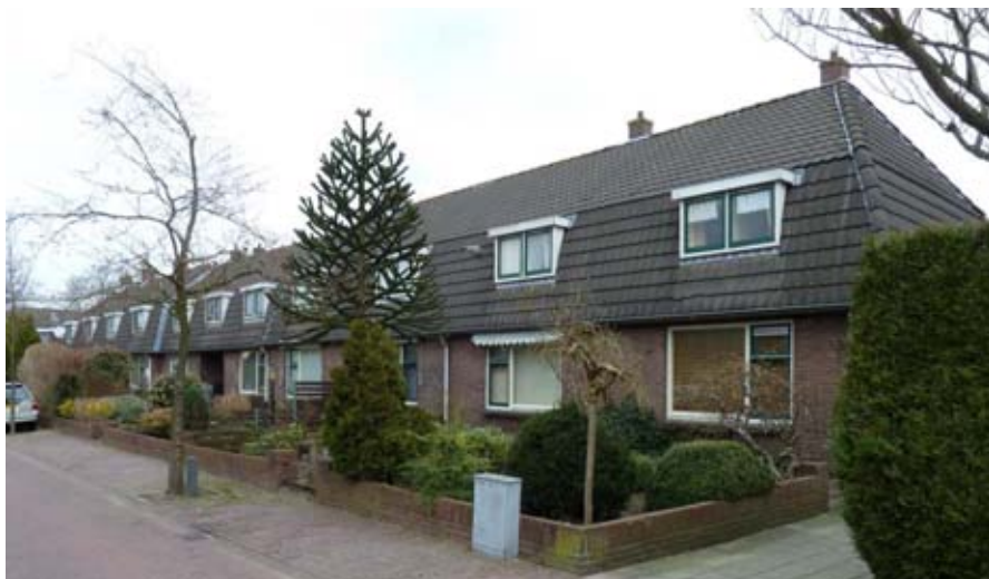
Rij van 10 woningen aan de Wolfskamerstraat, ontsloten vanaf de achterzijde.
