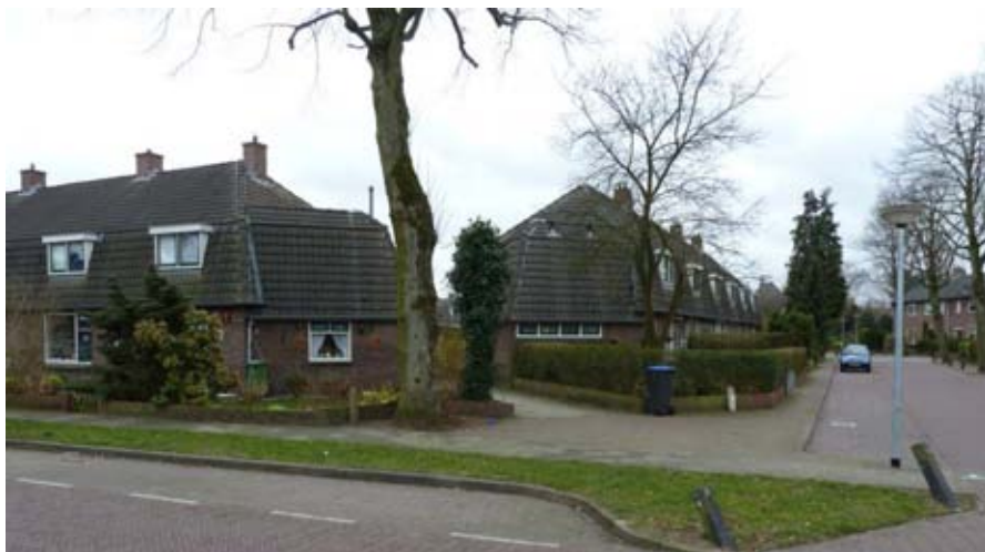
Hoekoplossing ter plaatse van de Prinses Irenestraat (links) en de Magdaleenstraat (rechts), geflankeerd door overhoekse aanbouwen met lagere kappen. Daartussen ligt een toegang tot het binnenterrein.
