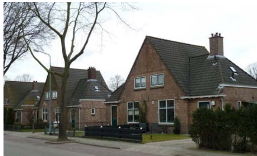
Dubbelwoningen aan de Haardstedelaan (fase 2).
