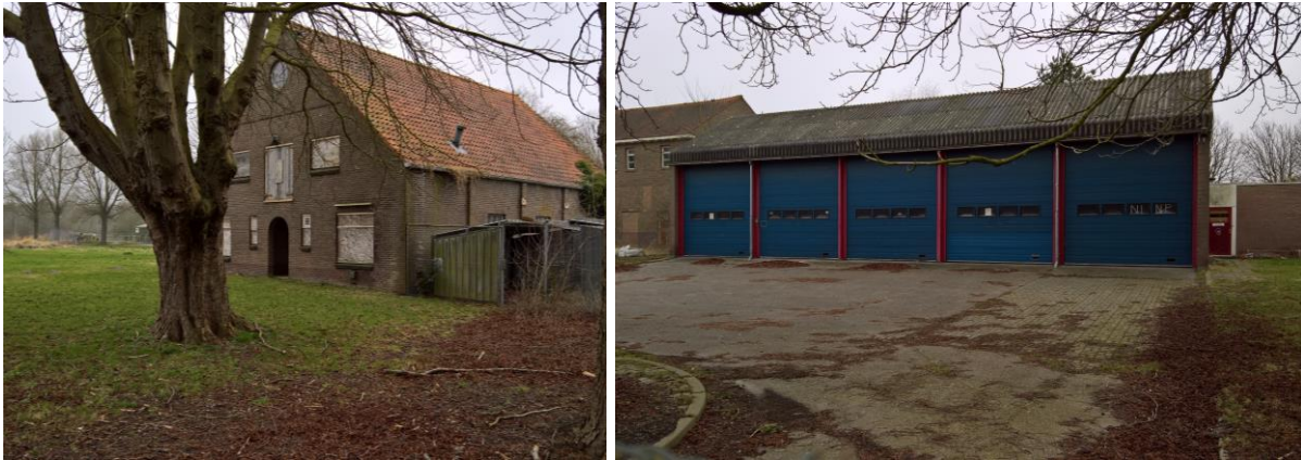
Afbeeldingen: boerderij (links) en stallingsgarage (rechts)
