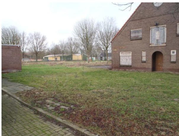
Foto 6: Deellocatie "Blokken achterzijde missiehuis"
