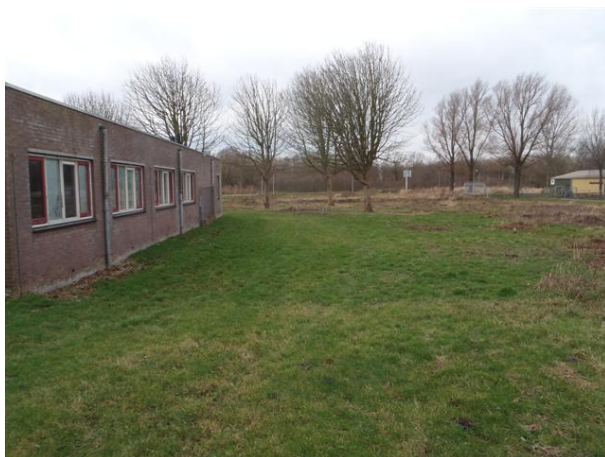
Foto 7: Deellocatie "Blokken achterzijde missiehuis"
