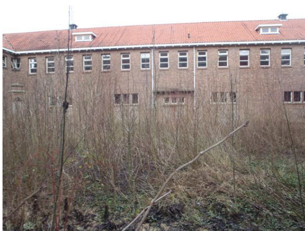
Foto 2: Deellocatie "Te overkappen binnenplaats"
