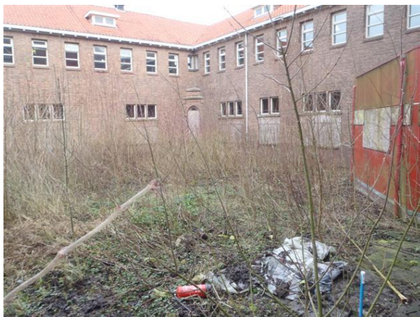
Foto 1: Deellocatie "Te overkappen binnenplaats"
