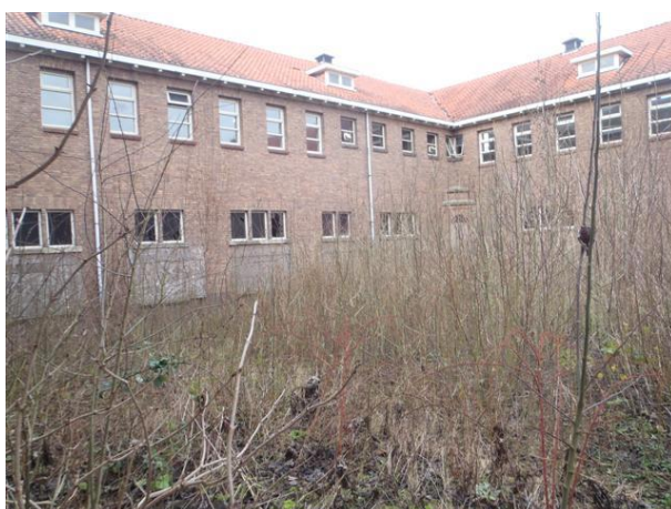
Foto 3: Deellocatie "Te overkappen binnenplaats"
