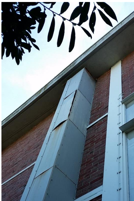
Foto 3 kieren tussen de bakstenen en het staal bieden mogelijk toegang voor vleermuizen
