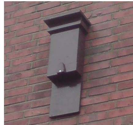
Figuur 3.7: Voorbeeld van een kleine vleermuiskast, geschikt voor, tijdelijke paar- en baltsverblijfplaatsen. (Foto: Martijn Bunskoek)
