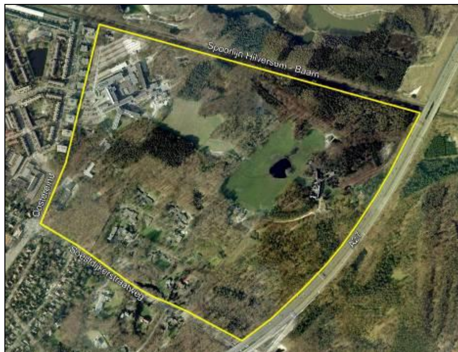
Figuur 2.1: Ligging van het plangebied 'De Monnikenberg' (gele omlijning) ten opzichte van de stedelijke bebouwing van Hilversum en infrastructuur.
