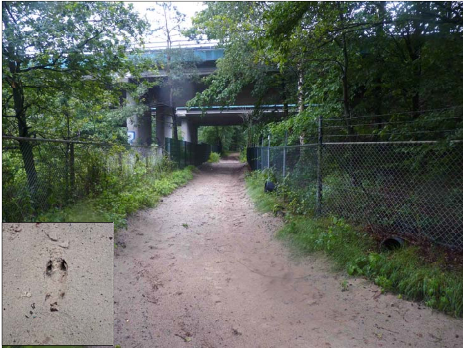
Afbeelding 12. Onderdoorgang onder de A27. Het betreft een voormalige toegangsweg naar een woning aan de oostkant van de A27. Links op de foto ligt de spoorlijn Hilversum - Baarn. De onderdoorgang is geschikt als faunapassage. Inzet: prent van een ree, die laat zien dat de onderdoorgang ook daadwerkelijk gebruikt wordt als faunapassage. Foto's: R.M. Koelman.
