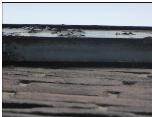
Aangetroffen kieren en spleten in het gebouw grenzend aan de Diepeweg.
