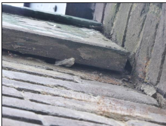
Aangetroffen kieren en spleten in het gebouw grenzend aan de Diepeweg.
