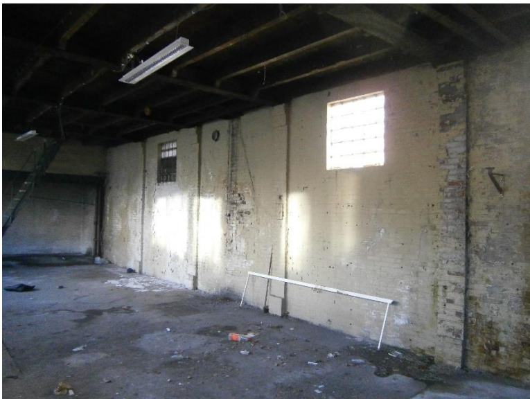
Afb.15. Zuidgevel (linker deel).
