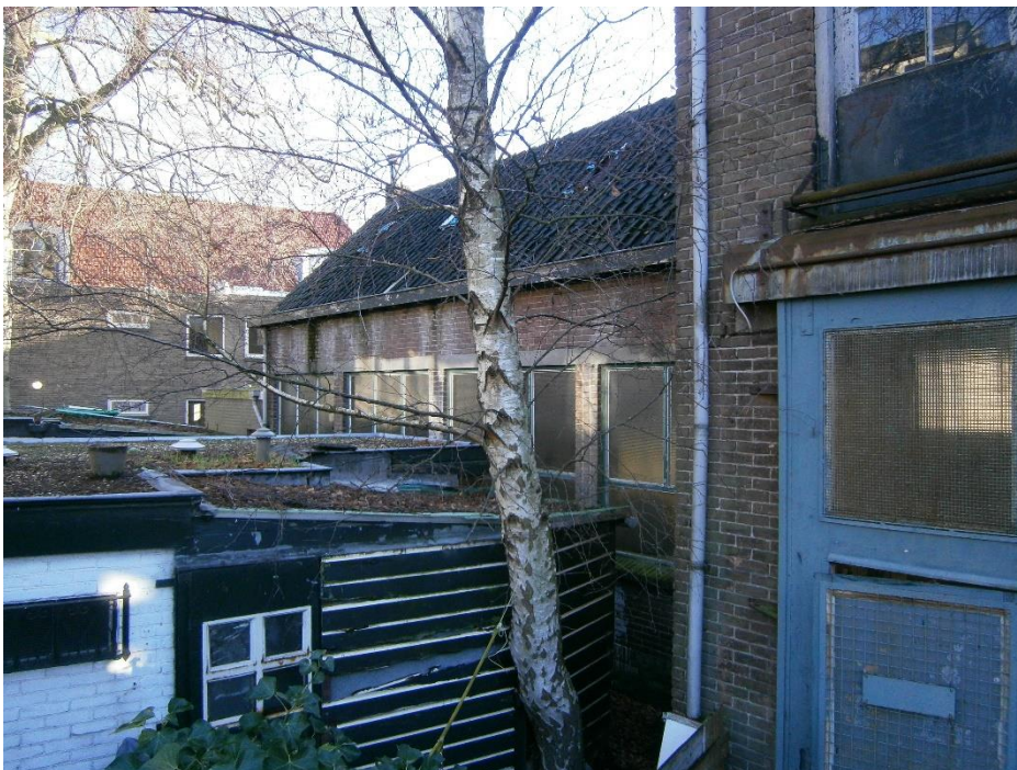
Afb.5. Voorgevel (noordzijde), linker deel.
