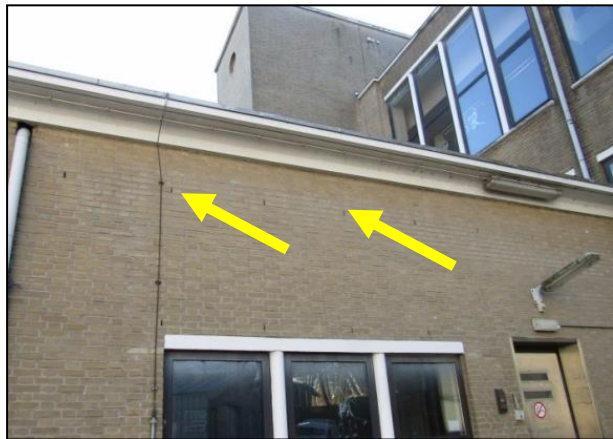
Figuur 12. Openingen in de muur die mogelijk toegang bieden tot de spouwmuur.
