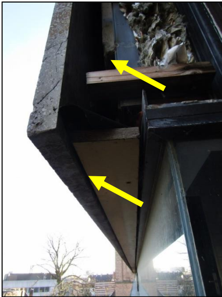
Figuur 13. Toegankelijke ruimte achter de betongevlplaten.
