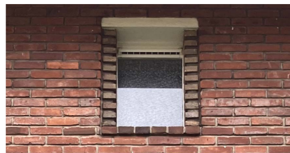
Metselwerkdetail rondom raamkozijnen
