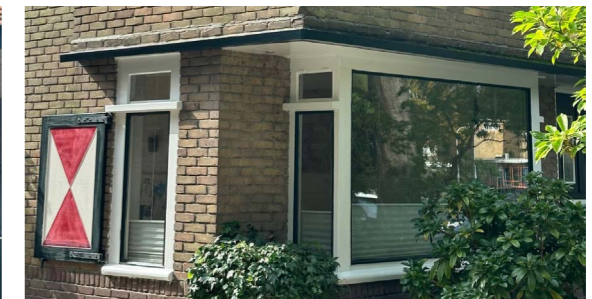
Kleine erkers aan de gevel
