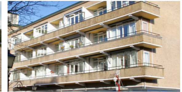
Balkons in materiaal van de gevel (Dudok)
