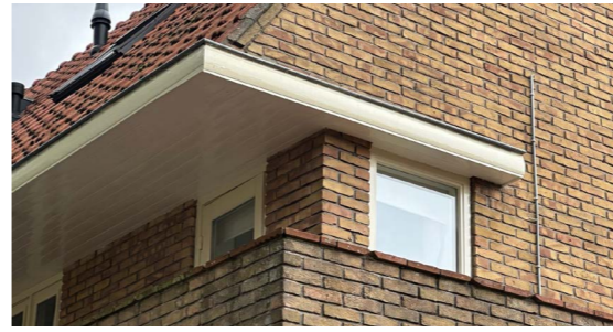
Kap overkraagt de onderbouw, Lorentzweg
