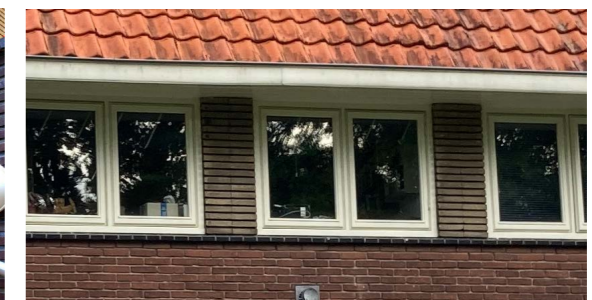
Metselwerkdetail rondom raamkozijnen, Lorentzweg
