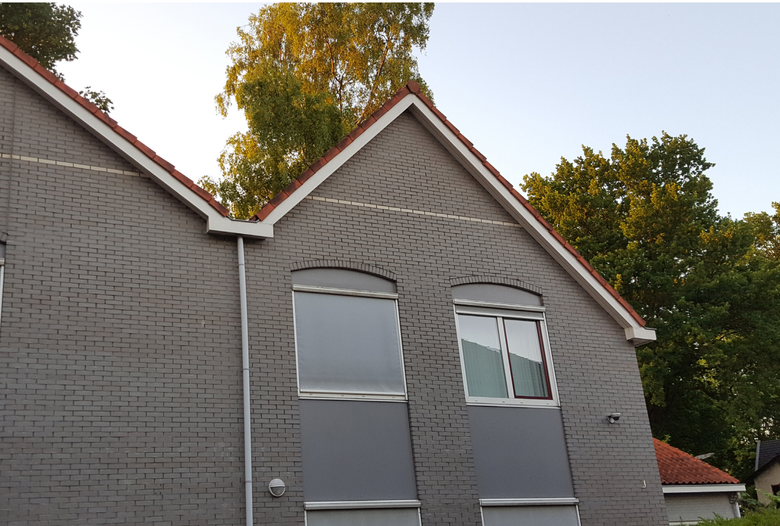
Projectgebied. Het te slopen kantoorpand.
