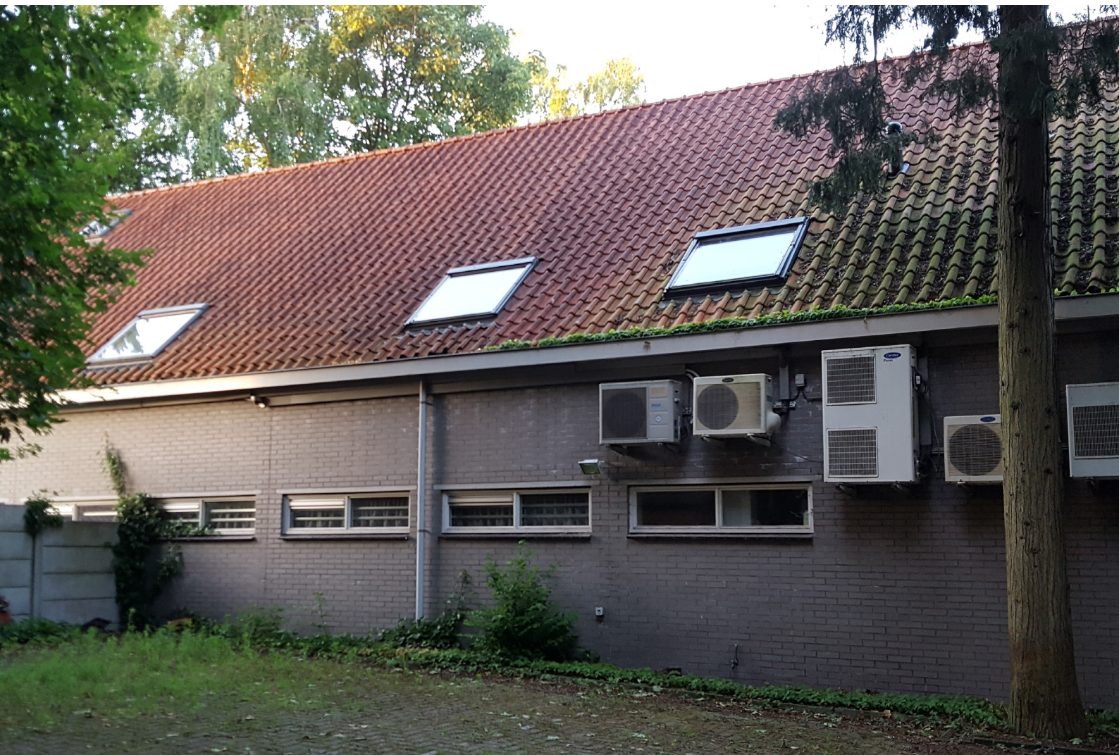
Projectgebied. Het te slopen kantoorpand.
