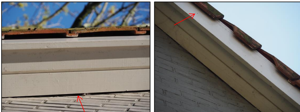
Mogelijkheden voor een verblijfplaats van gebouwbewonende vleermuizen in het kantoorpand. Links: één van de kieren tussen de muur en de windveer. Rechts: ruimte vanwege kapotte dakpannen. Onder de dakpan aan de linkerkant is een mogelijke vleermuiskeutel zichtbaar (zie rode pijl).
