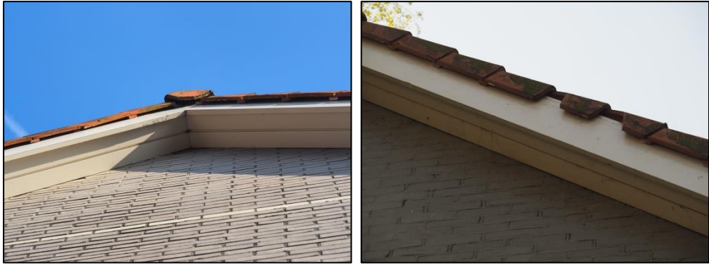
Mogelijkheden voor een nestplaats van de gierzwaluw. Dit betreft ruimtes onder de nok van het dak (links) en ruimtes onder dakpannen (rechts).
