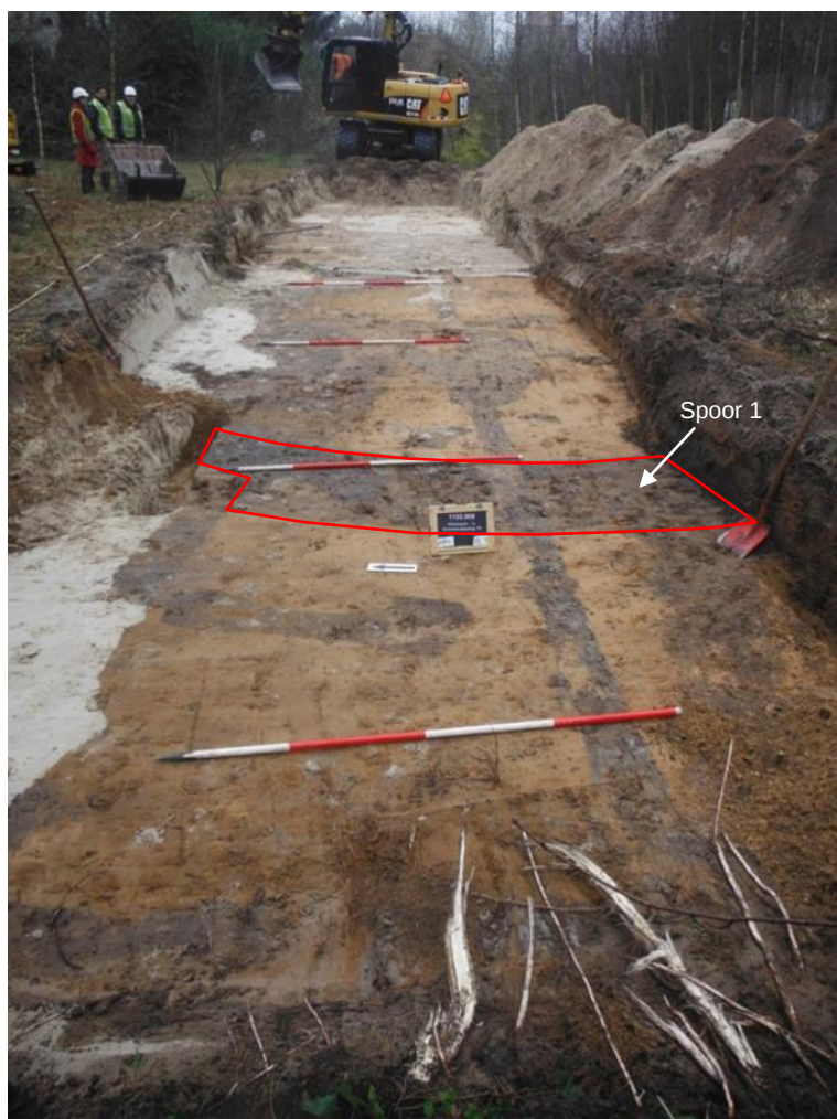
Afbeelding 7 Vlaktfoto aangelegde proefsleuf
