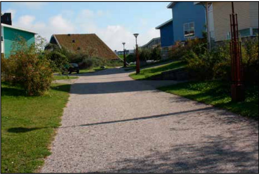
Voorbeeld asfalt met afstrooilaag van schelpen
