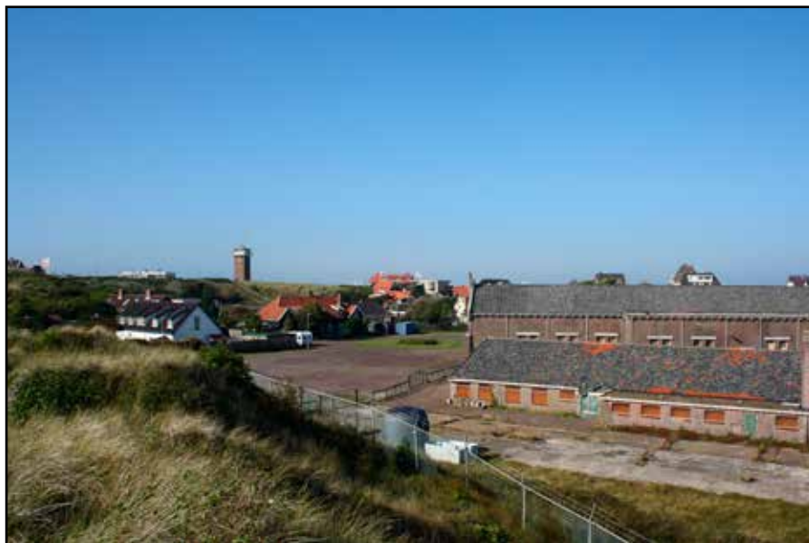
Zicht vanaf de duinen richting de grote loods
