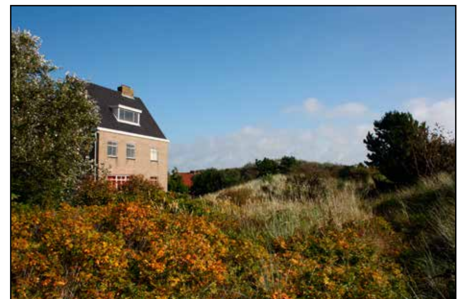
Karakteristieke overgang vrijstaande woningen richting het duinlandschap
