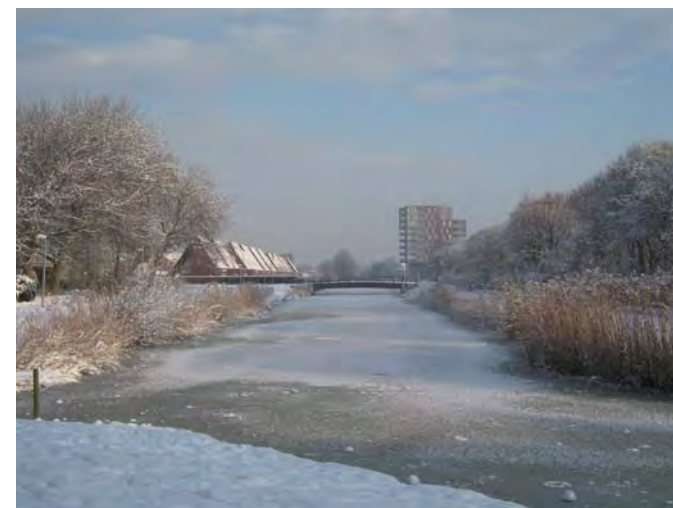
12. Richting woontoren aan IJsselmeerstraat
