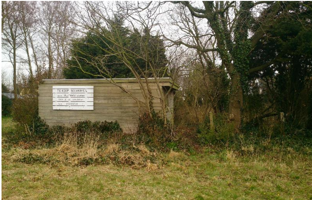
Figuur 1 De planlocatie betreft een kavel met twee schuren aan de Lijsterbes te Heiloo. Beide schuren zijn opgetrokken uit houten panelen en een bitumen dak.
