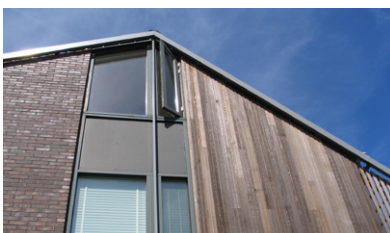
Grijs kozijn met hout en metselwerk
