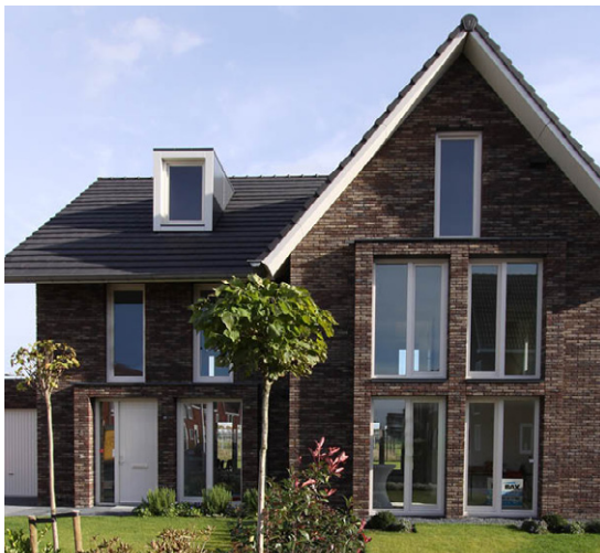
metselwerk in lichtbruine tint.
