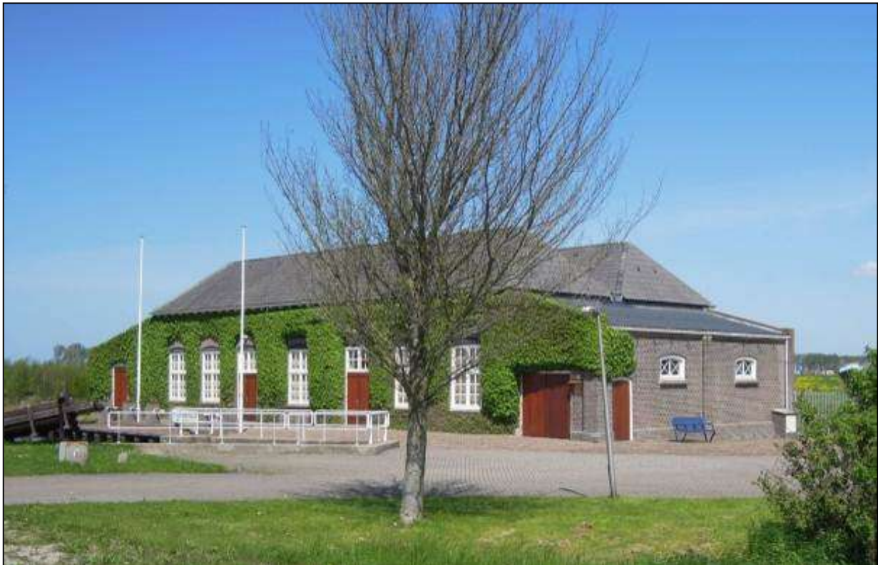
Afb. 43: Het poldergemaal aan de Huygendijk 17 nam aan het einde van de negentiende eeuw een groot gedeelte van de maalcapaciteit van de windmolens over en zorgde daardoor voor een stabielere waterafvoer van de polder Heerhugowaard.
