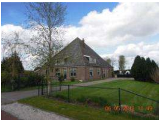
Jan Glijnisweg 1 (stolp op redelijk ruim erf)
