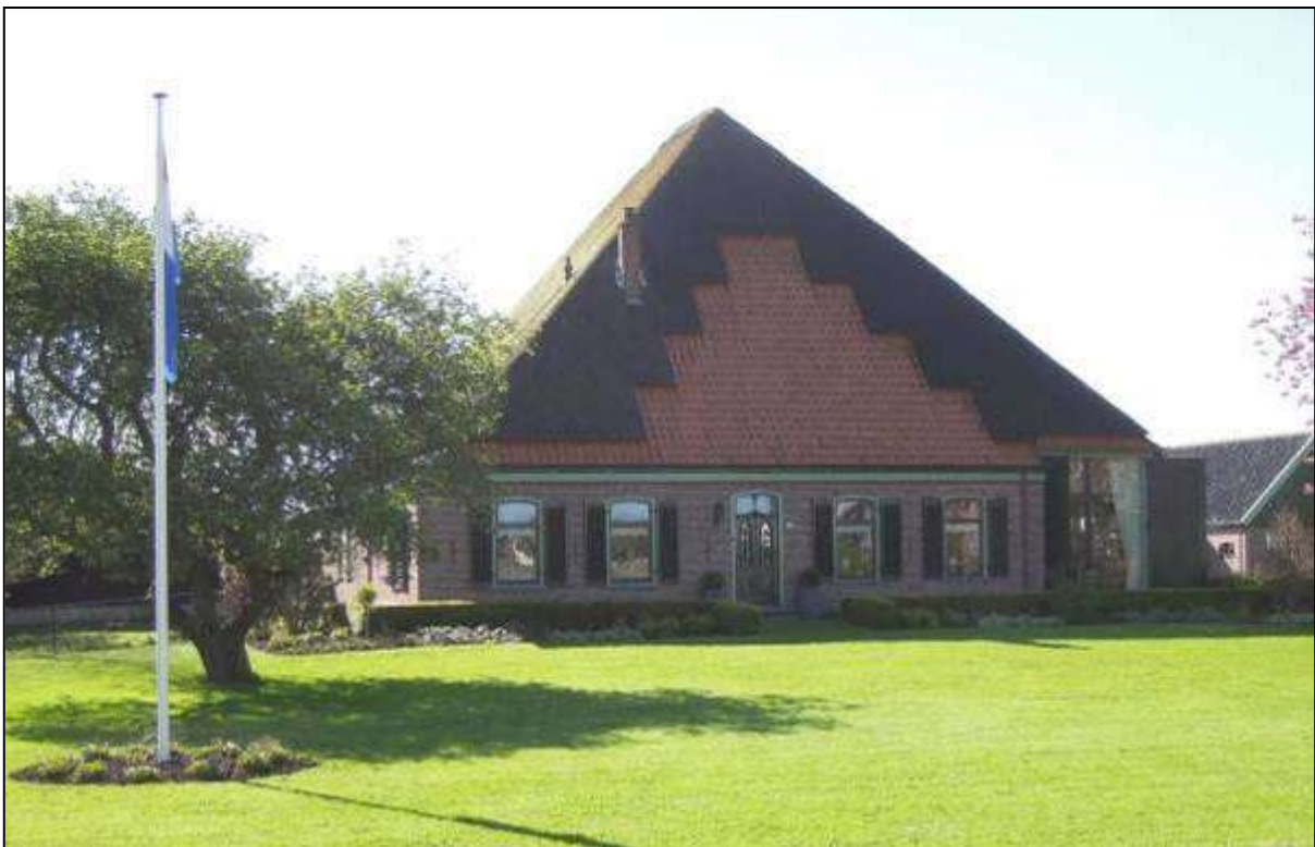
Afb. 36: Aan de Middenweg 6, staat een oude stolpboerderij met een getrapte dakspiegel en waarin een oudere kern aanwezig is, dan deze vanaf de buitenkant doet vermoeden.
