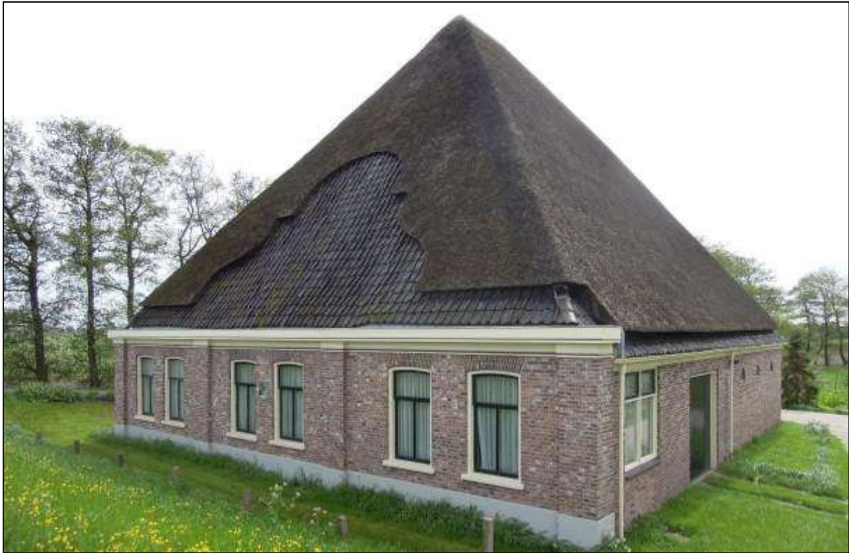
Afb. 11: De stolp op het adres Oostdijk 2; een stolp op een stukje “voorland”.
