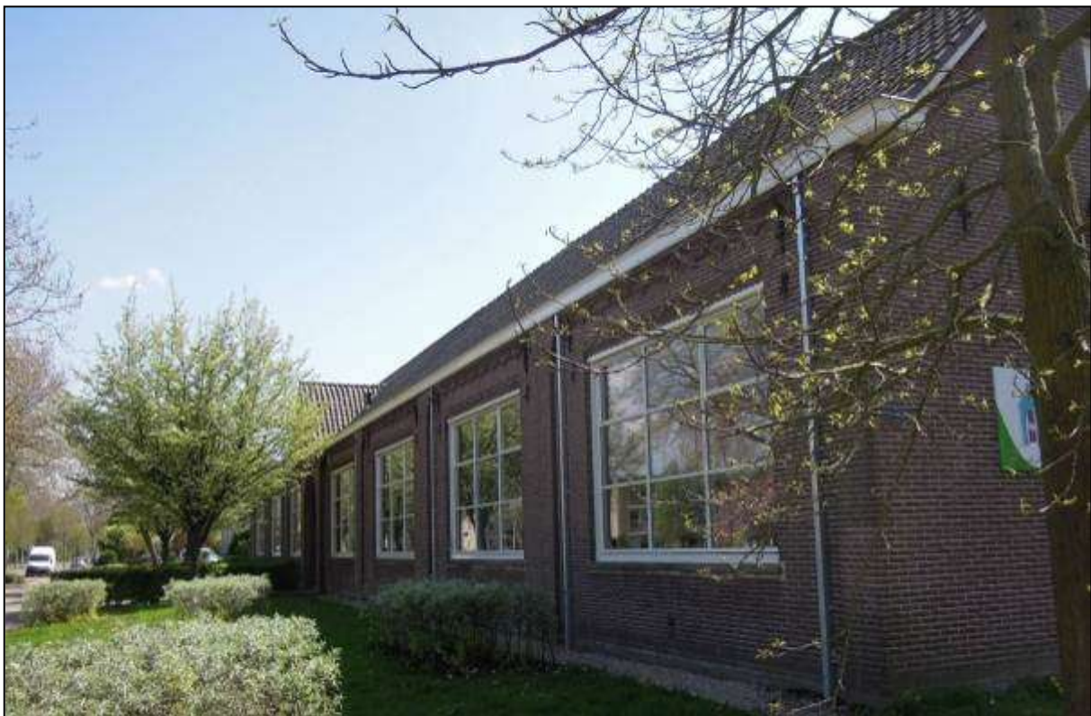
Afb. 52: De rooms-katholieke lagere school aan de Van Veenweg 4 werd in de jaren 1911-1912 gebouwd.
