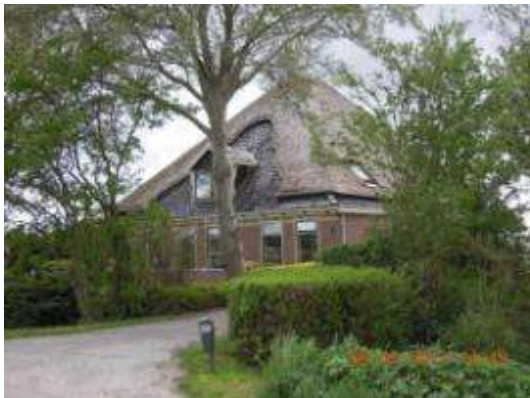
Veenhuizerweg 29, stolp met klokvormige spiegel
