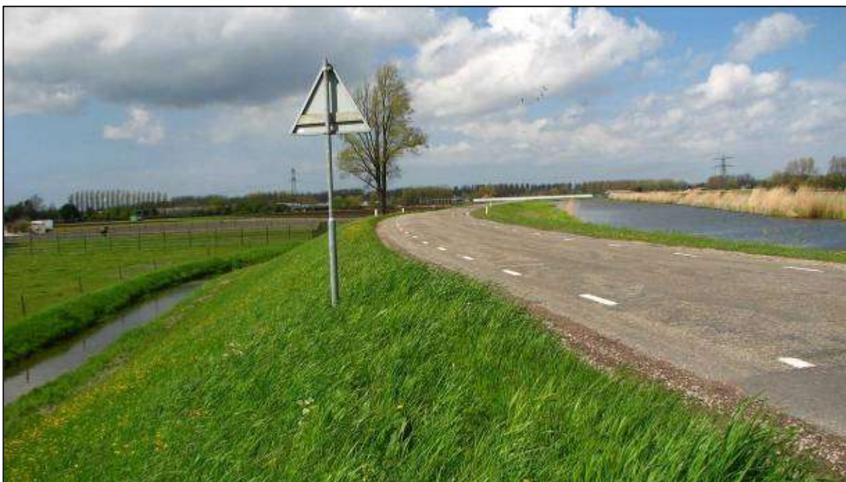
Afb. 22: De ringdijk en -vaart van de polder Heerhugowaard gezien vanaf de Oostdijk. Links van de dijk ligt het lage land van de polder en rechts het hoge water in de ringvaart, dat in plaats van de oorspronkelijke waterboezem voor de afwatering van de polder moet zorgen.
